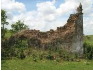
Ruínas da capela. Engenho Guaribas, Alagoas. Arquivo Estudos da Paisagem, 2007.
